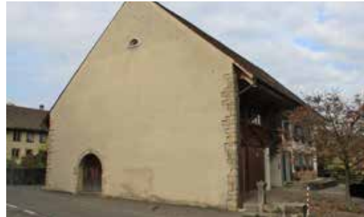
Brandmauer mit Lünettenfenster
