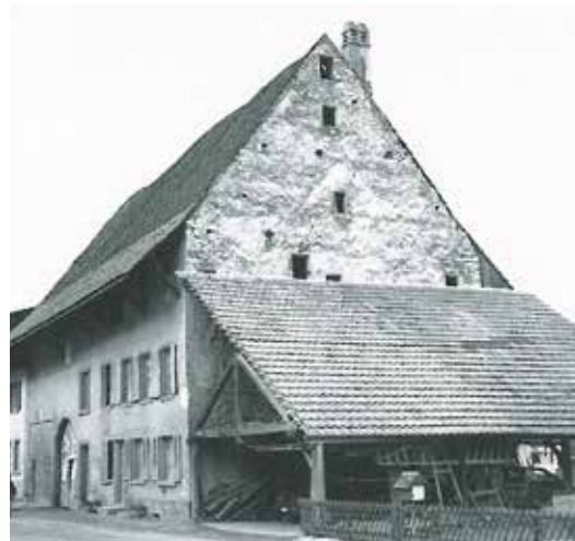
Giebelseitiger Nebenbau mit Pultdach
