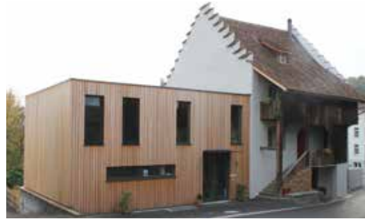
Nebenbau mit Flachdach
