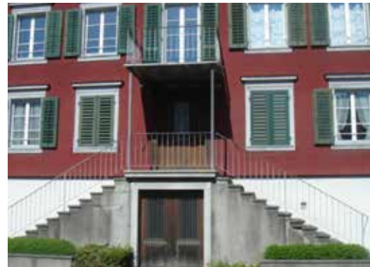
Treppenanlage mit Haupteingang und darüberliegendem Balkon, an Repräsentativbau
