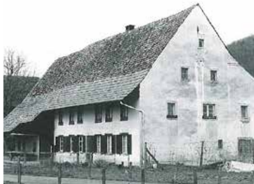
Lage der Fenster unter dem Vordach
