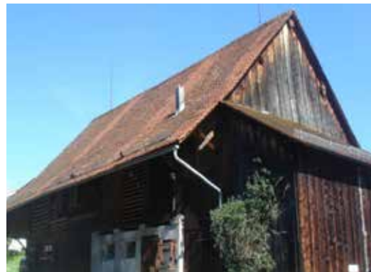
Giebelseitiger Nebenbau mit Pultdach
