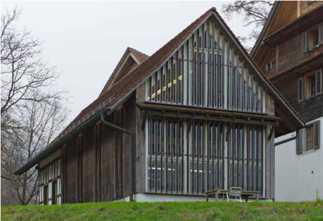
Umgebauter, freistehender Nebenbau
