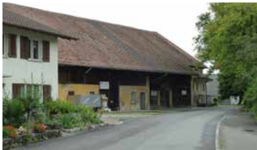
Schiefwinklig zur Strasse stehende Bauten engen den Strassenraum kurz und scharf ein
