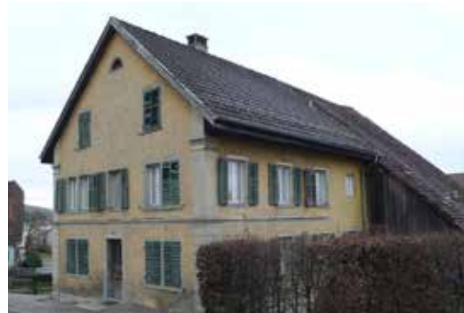
Haus mit Nebenbau unter der Verlängerung der Satteldachflucht
